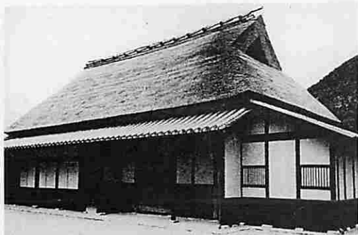
兵庫県指定有形文化財・本岡家住宅
