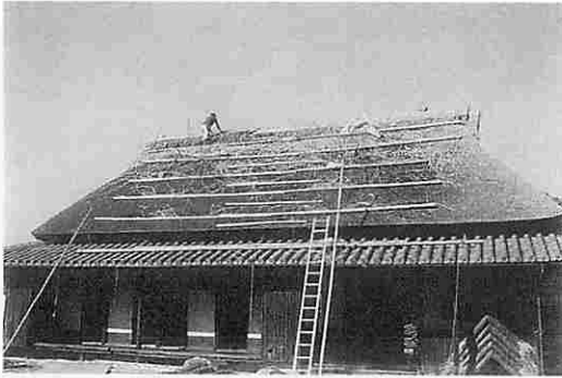
本岡家住宅 屋根補修状況
