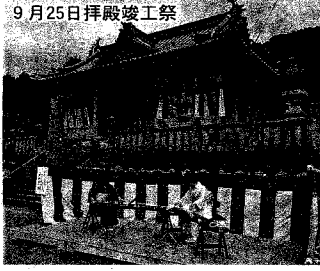
9月25日拝殿竣工祭
